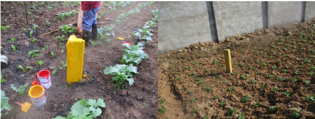
管道作业带旱地复耕
