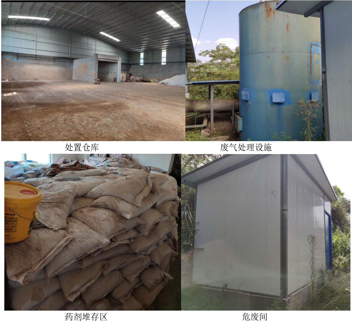
图 4-1 各重点设施区域现场照片
