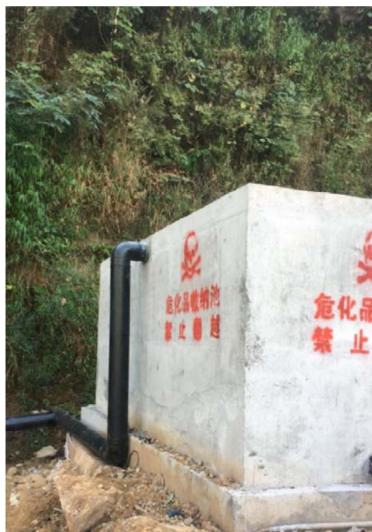
东桥头事故池
